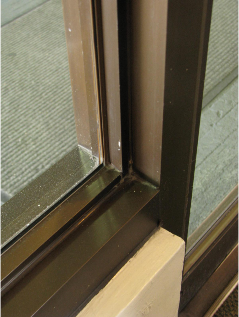
18. November 2011 11:00, die Probleme der Philippinen sind entdeckt: Nur eine Scheibe um tropische Hitze von Innenraumtemperatur zu trennen.
